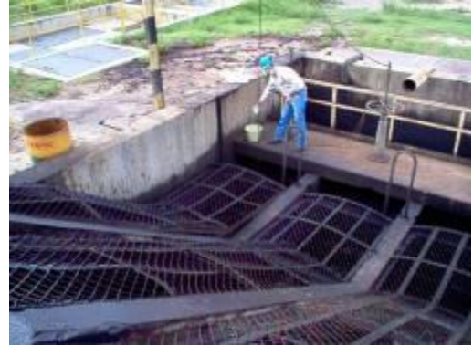
Contrato MA-0030143 Año 2013 Tubería, ECOPETROL S.A
