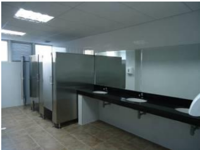
Contrato 3003185 Año 2018 Mantenimiento menor de instalaciones policlínica
