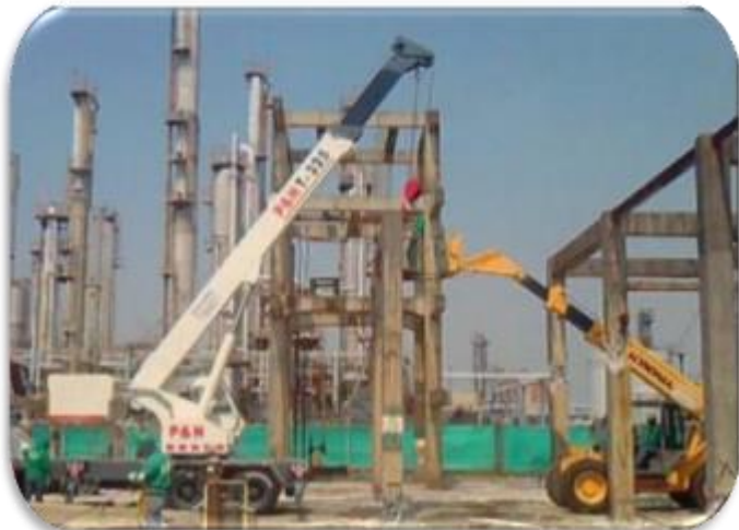
Contrato 4023439 Año 2009 Demolición Planta Alcanos
