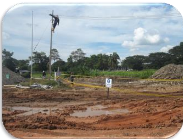
Contrato MA 0011139 Año 2012 Obras eléctricas locaciones
