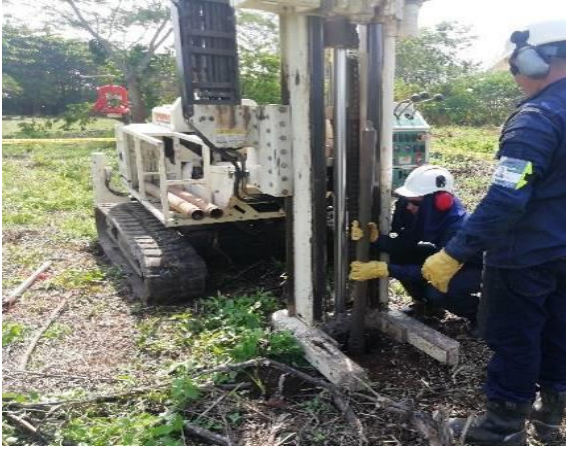
Contrato 3028327 Año 2020 Perforación de pozo para monitoreo
