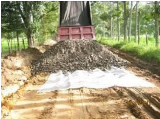
Contrato MA-011139 Año 2012 Vía Pozo Aullador
