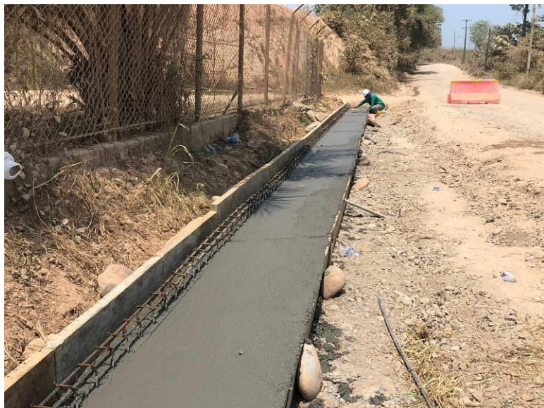
Cunetas Via nacional Contrato 3028575
