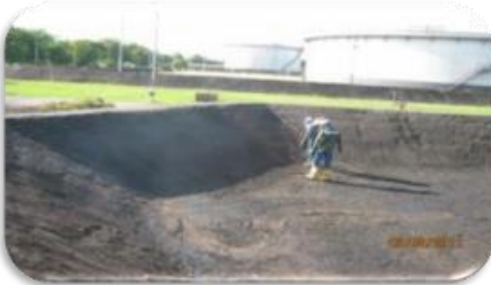
Contrato 4032230 Año 2012 Reparación de Diques Materias Primas
